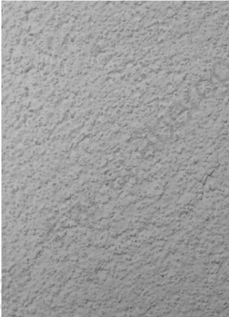
PUTSSTRUKTUR 19. ORGANISK HANDDRAGEN YTPUTS, KORNNMAX 1,5 MM.
