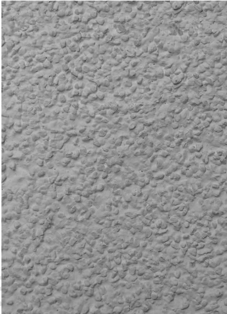
PUTSSTRUKTUR 21. ORGANISK HANDDRAGEN YTPUTS, KORNNMAX 3 MM.
