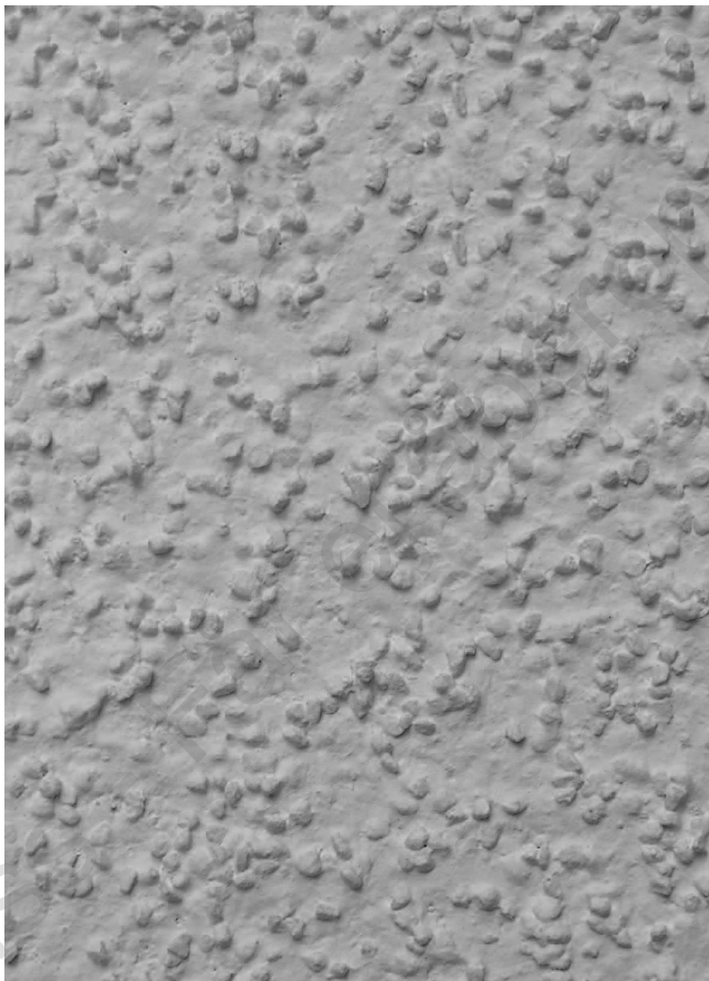
PUTSSTRUKTUR 15. ORGANISK SPRUTAD YTPUTS, KORNNAX 3 MM.
