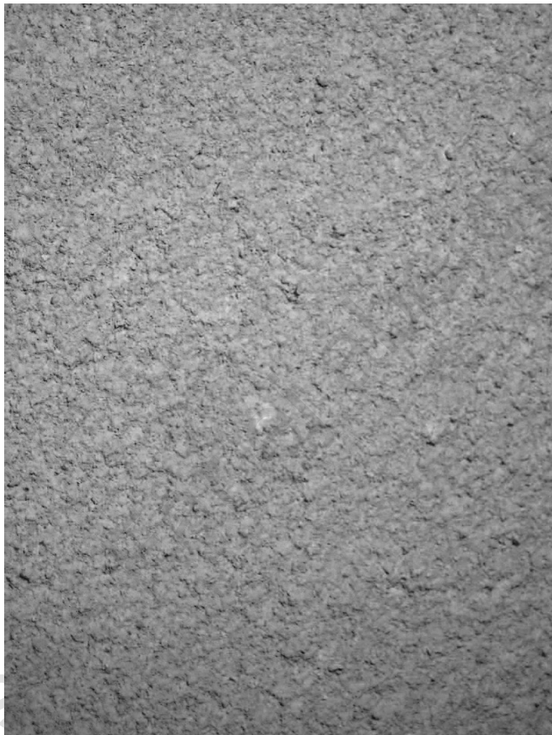
PUTSSTRUKTUR 10. OORGANISK YTPUTS, STÄNKPUTS GROV, KORNNAX 3 MM.
