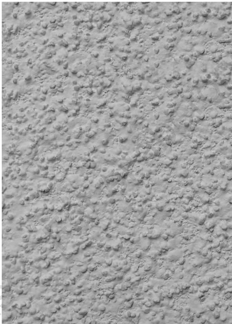
PUTSSTRUKTUR 14. ORGANISK SPRUTAD YTPUTS, KORNNAX 2 MM.
