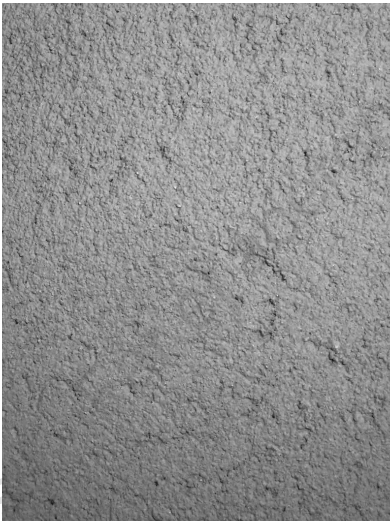
PUTSSTRUKTUR 3. OORGANISK YTPUTS, SLÄTPUTSAD BRÅDRIVEN, KORNMAX 2 MM.
