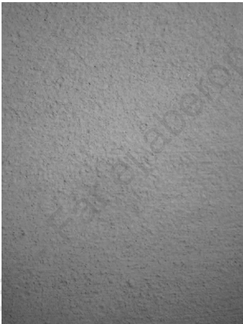
PUTSSTRUKTUR 1. OORGANISK YTPUTS, SLÄTPUTSAD MÅLAD, KORNMAX 0,5–1 MM.
