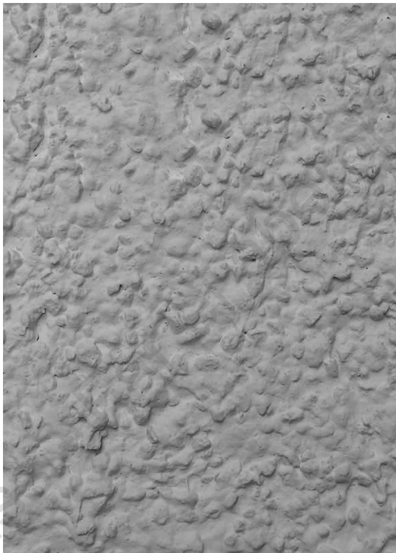
PUTSSTRUKTUR 22. ORGANISK HANDDRAGEN YTPUTS, KORNNAX 6 MM.
