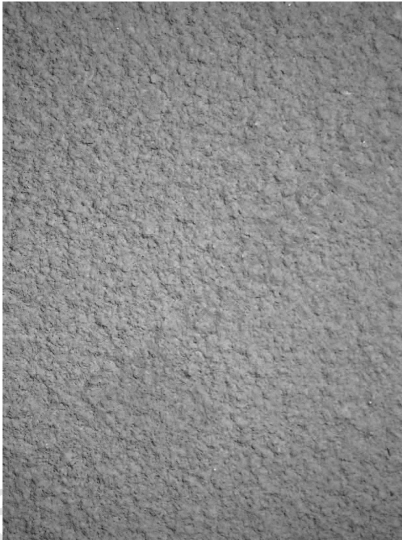
PUTSSTRUKTUR 9. OORGANISK YTPUTS, STÄNKPUTS FIN, KORNNMAX 2 MM.
